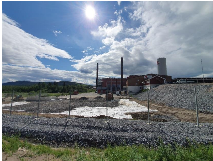
Fig 2. Bild på fjärrvärmeverket som är beläget i planområdets norra del.
