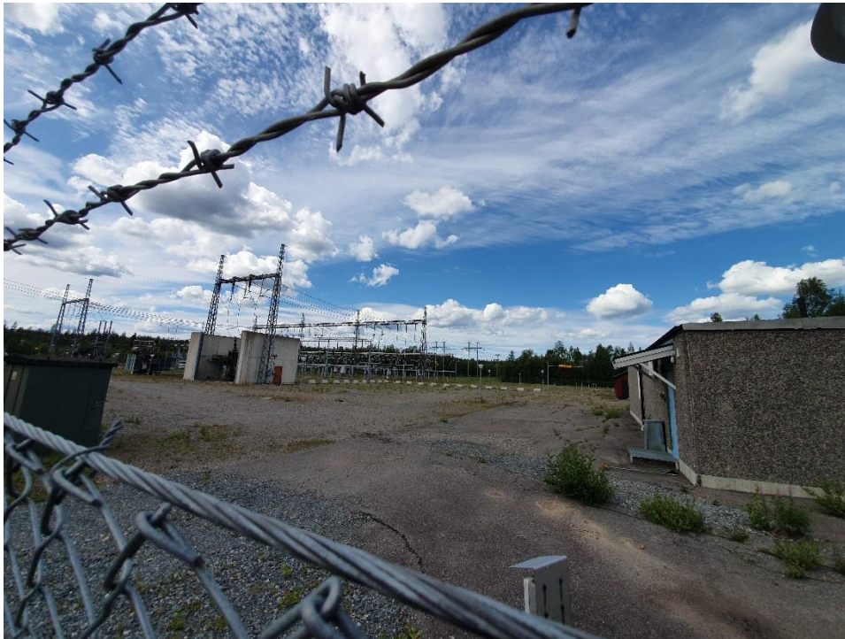
Fig 4. Bild på ställverket som angränsar till planområdets södra del.
