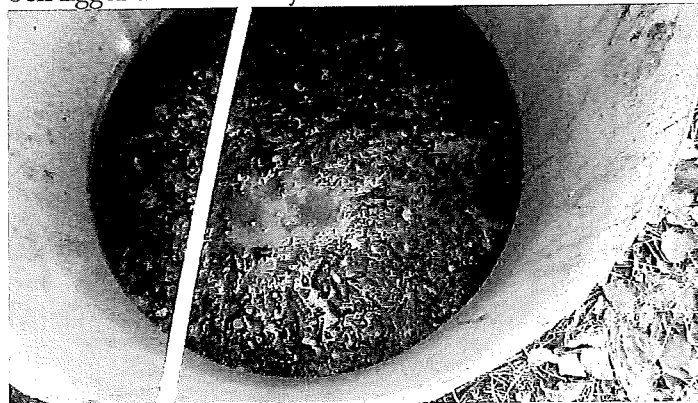
Foto 1. Taget vid första inspektionen i juni.
