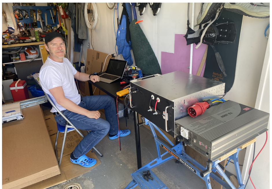
Hemma i garaget har Peter Strand byggt en powerbank av ett batteri från en krockad elbil. Powerbanken kan ladda en elbil så att den kan köra tre mil.
