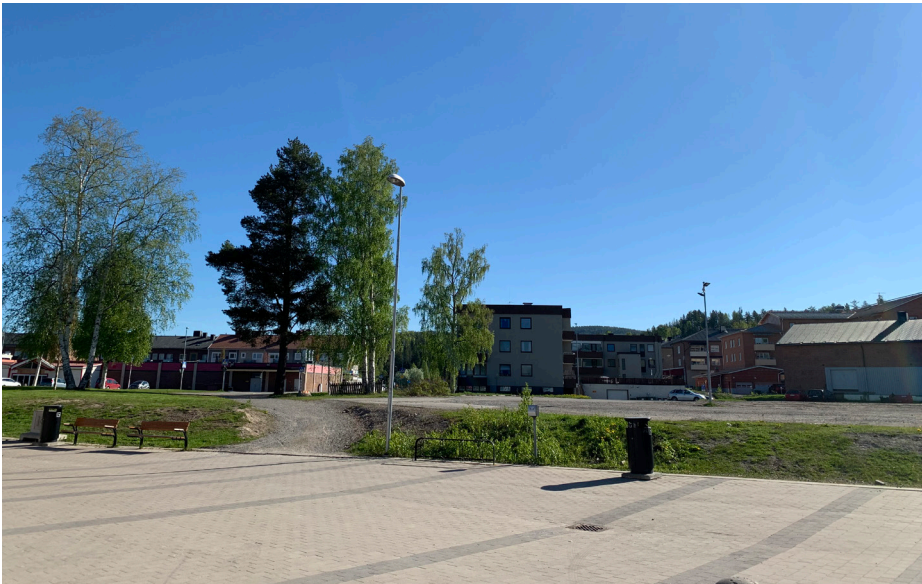
Här på Lekentomten kommer det nya hyreshuset att byggas. Foto: Sofia Lundberg
