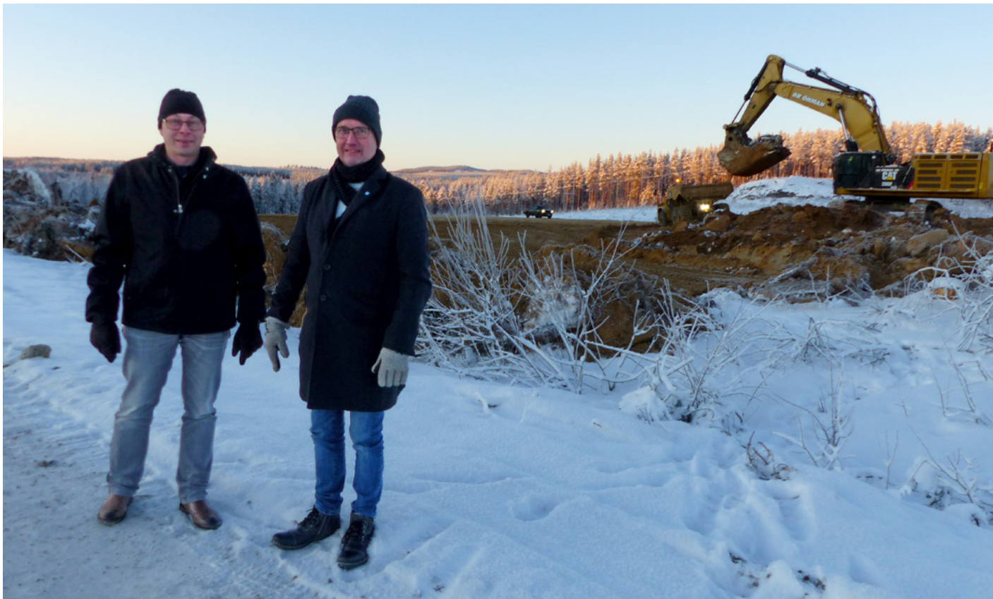
Sambhällsbyggnadschef Roger Tuomas och kommunalråd Tomas Egmark konstaterar nöjda att schaktningsarbetet för de nya industritomterna på Norra Nyfors har kommit igång bra.
