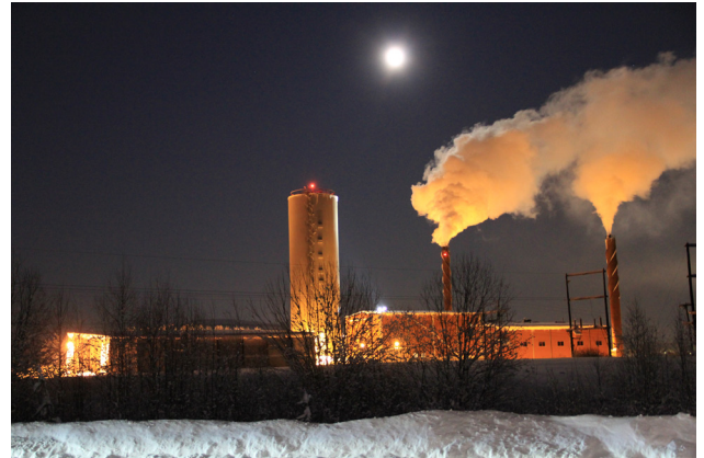
Älvsbyns Energis fjärrvärmeanläggning
